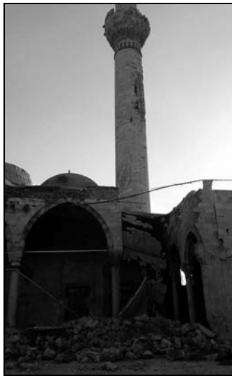
Fig.12 Pjesa e dëmtuar e minares Fig. 13 Dëmtimi i kupolës së madhe të Sallës së Lutjeve
