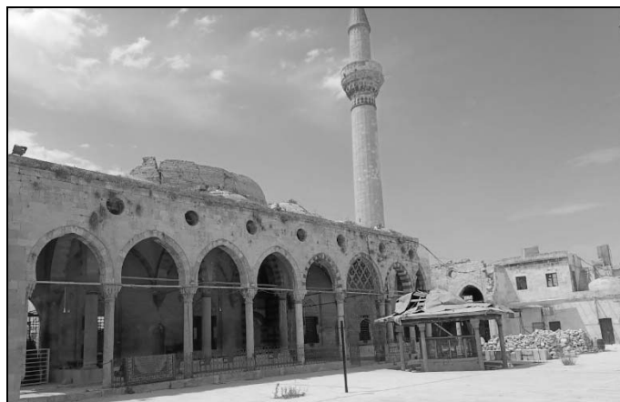
Fig.14 Dëmtimet e harqeve dhe portikut
