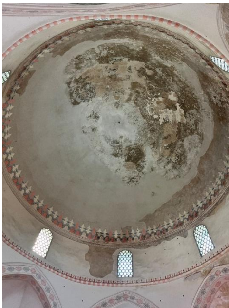
Fig. 9 Pikturimi polikrom i diametrit të kupolës dhe dëmtimet e saj nga lagështia (E.Shipoli, prill 2023)
