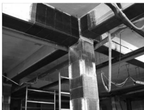
Fig. 1.3. Përforcim me FRP i elementëve prej betoni të armuar
